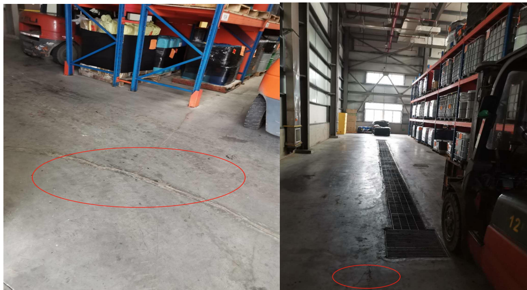
图 1-7 有机废物暂存间防渗地面开裂照片
